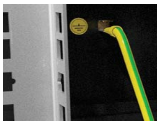
Используя заземляющие провода, подключите все металлические элементы шкафа к предусмотренным для них узлам заземления. На завершающем этапе подключите главный заземляющий контакт шкафа к существующей в здании общей системе заземления.
