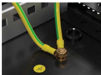
Используя заземляющие провода, подключите все металлические элементы шкафа к предусмотренным для них узлам заземления. На завершающем этапе подключите главный заземляющий контакт шкафа к существующей в здании общей системе заземления.
