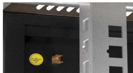
Как крыша, так и основание шкафа содержат по 2 резьбовые шпильки (всего 4 шт.), через которые с помощью проводов заземления можно подключить все металлические элементы шкафа, оснащенные наконечниками под разъёмный соединитель (одно- или двусторонние контакты типа лепесток).
