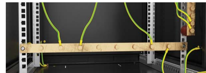
При большом количестве оборудования устанавливать в шкафу можно не только одну 19-дюймовую шину, но добавлять также и шины других размеров.
