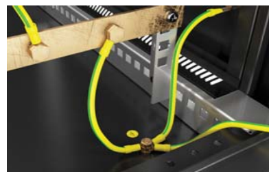
Заземляющая шина подключается к одной из шпилек заземления. К установленной шине необходимо подключить внешний заземлитель, а также все установленное оборудование. Для каждой единицы оборудования должен использоваться отдельный заземляющий провод.
